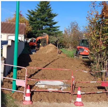
Création d'un réseau d'eaux pluviales de la Rue des Clos à la Rue des Sources permettant, d'une part, de collecter les eaux du réseau existant et d'autre part de pouvoir recevoir le volume important lors d'orage ou de longue précipitation du bassin versant « Le Noyer aux Coqs » afin de résoudre les problèmes d'inondation des habitations dans la Rue des Clos.
